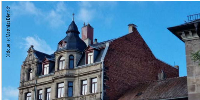
Abb. 3: In der Musterbauordnung fehlen konkrete Vorgaben, wie mit bestehenden Gebäuden umzugehen ist.
